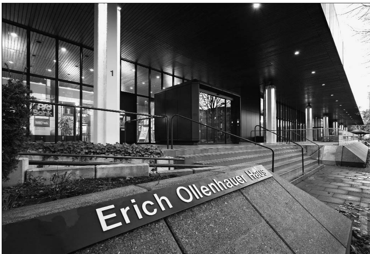
Das sanierte Erich-Ollenhauer-Haus in Bonn
