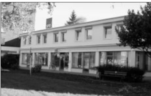
Sanierung im Jahr 2003: Das „Paul-Hug-Haus“, Sitz der Geschäftsstelle der Unterbezirke Wilhelmshaven, Friesland und Wittmund, am Rathausplatz in Wilhelmshaven.
