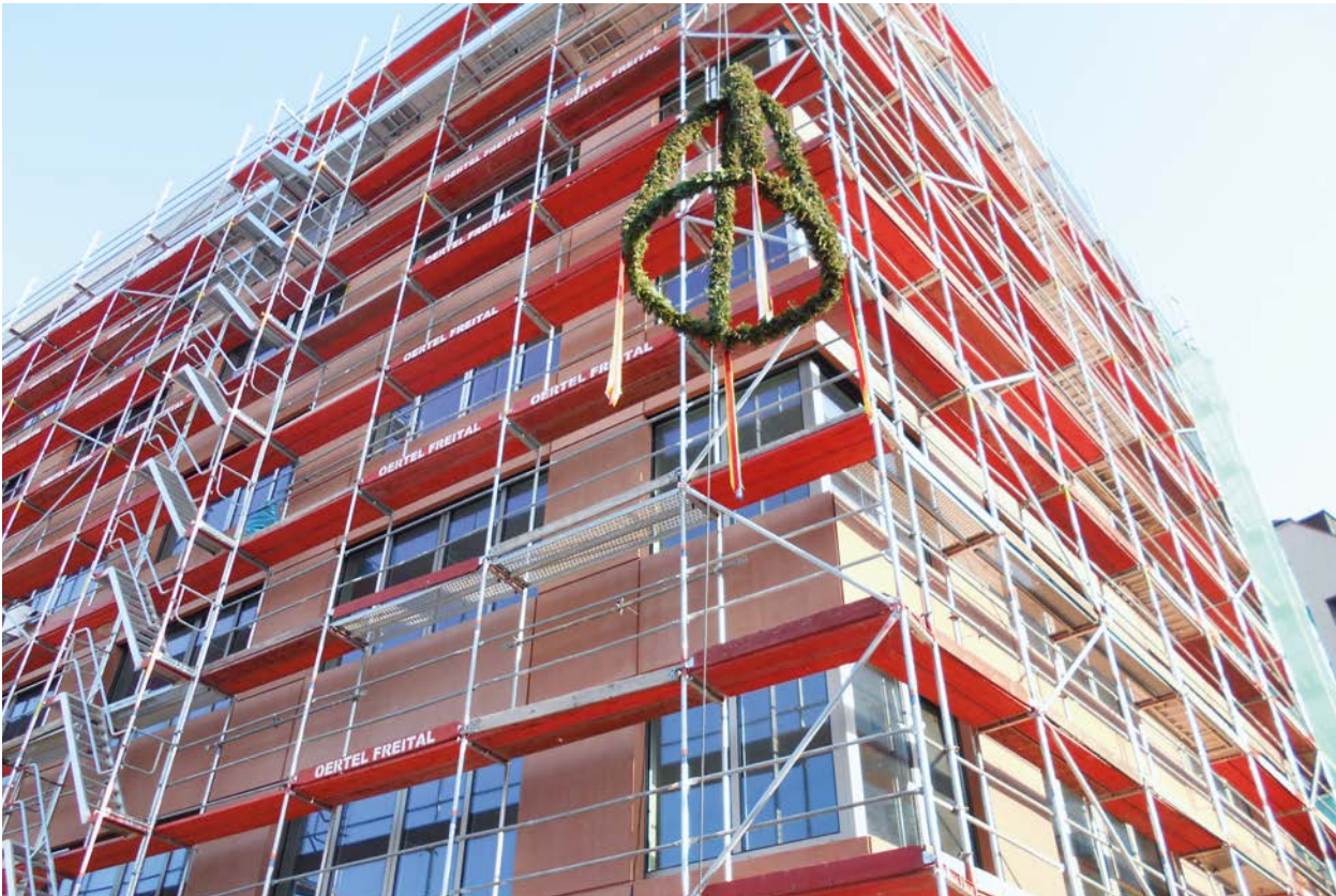
Herbert-Wehner-Haus Dresden – Richtfest am 28. September 2018. Foto: Konzentration GmbH
